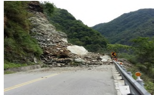
台8線中橫公路土石流(Ettody新聞2022/6/2)
