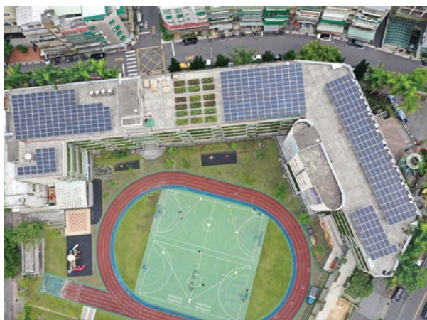
▶ 萬興國小設置太陽發電系統
