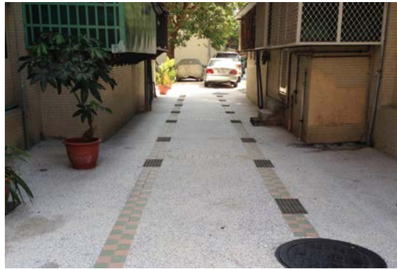
► 污水下水道接管工程巷弄綠美化
