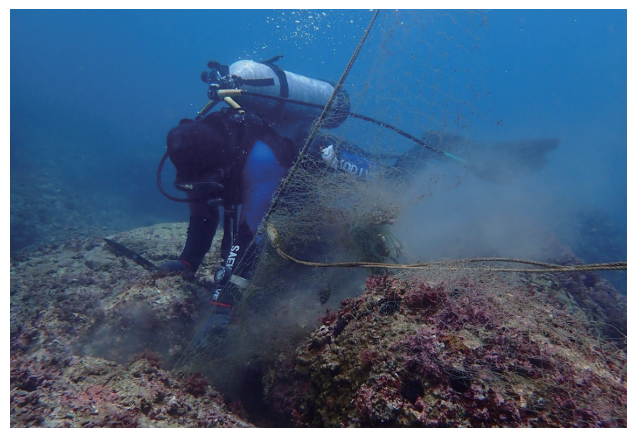
▲圖 2-28 潛水人員於海底進行覆網清除作業
