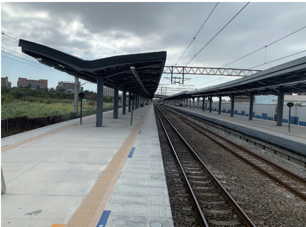
▲圖 2-18 北湖站月台齊平工程
