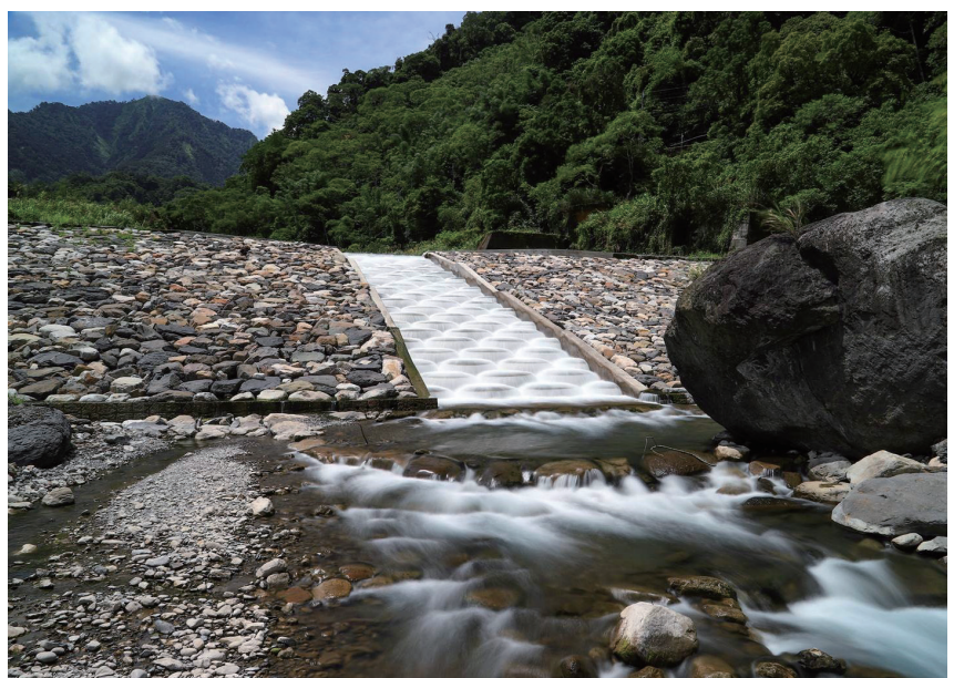
▲圖 2-29 改善臺中烏石坑溪長榮橋上游防砂壩
