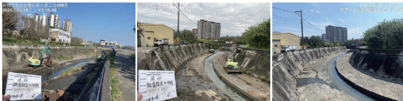
區域排水(東大排)清淤作業
