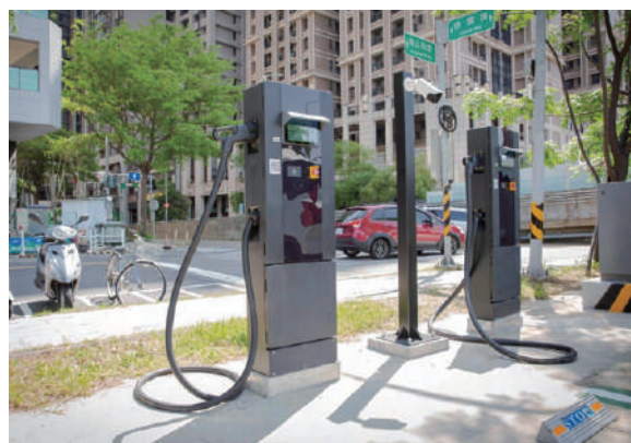
充電樁設置情形
