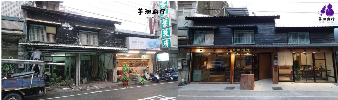
圖 4.11.6-1、嘉義市舊屋力補助創特色店（修繕前後對照圖）
