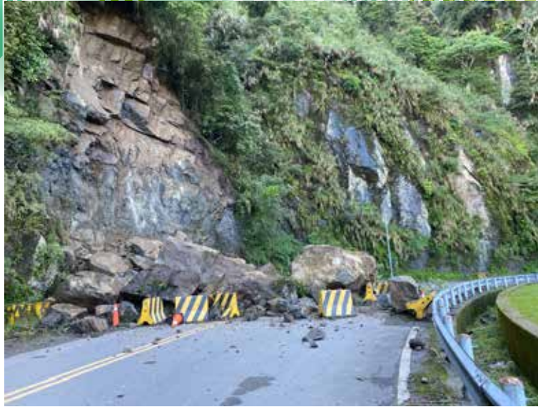
▲投51杉林溪路段於颱風豪雨期間因山區豪大雨造成邊坡崩塌，導致道路中斷
