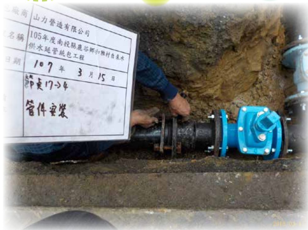
▲加壓站自來水接管工程
