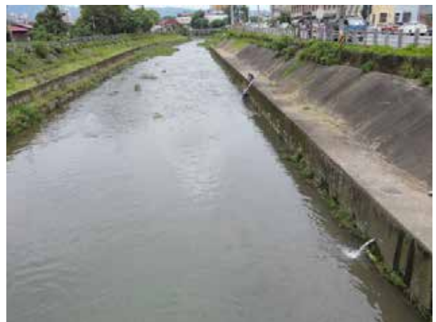
▲育英橋上下游礫間接觸設施，截留部分生活污水進行自然淨化工法改善水質
