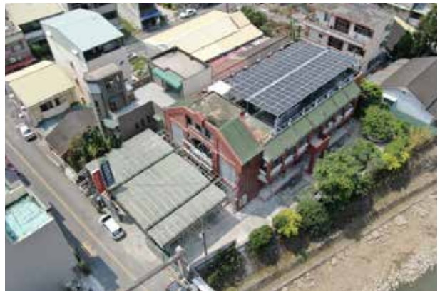
集集鎮公所-長青會館暨和平里集會所活動中心 裝置容量：34.98kW(瓩) 併聯日期：110.4.8
