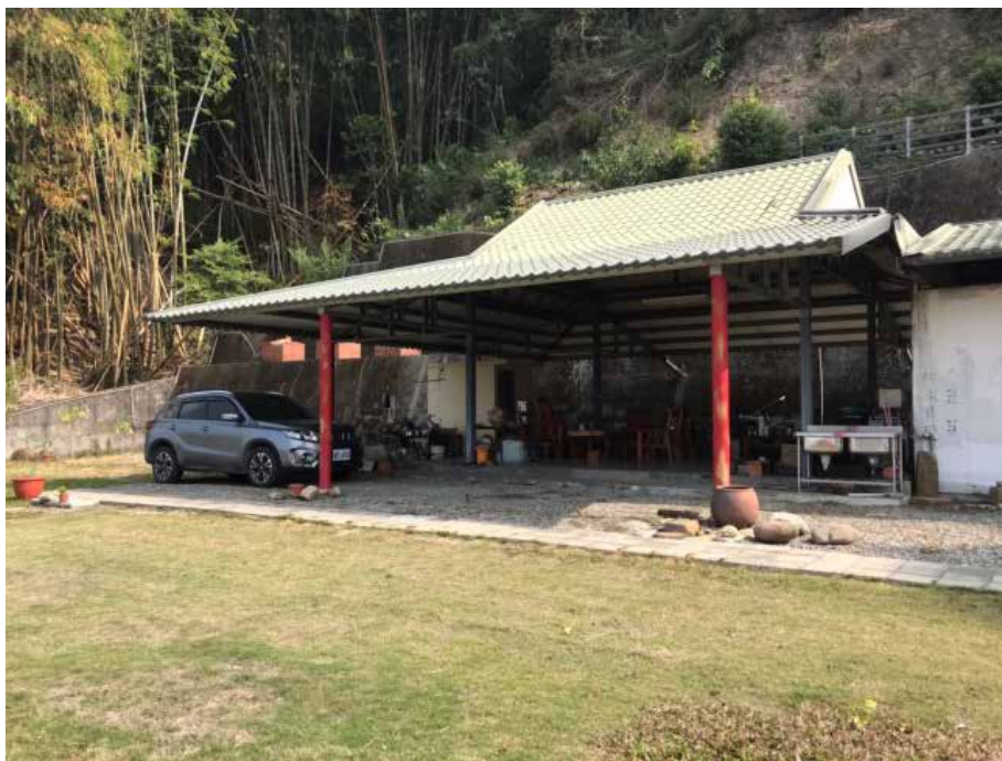
▲水里鄉某建物違規設置擋土牆、道路、建物作非林業使用，依據森林法第6條第2項及第56-1條裁處新台幣6萬元整
