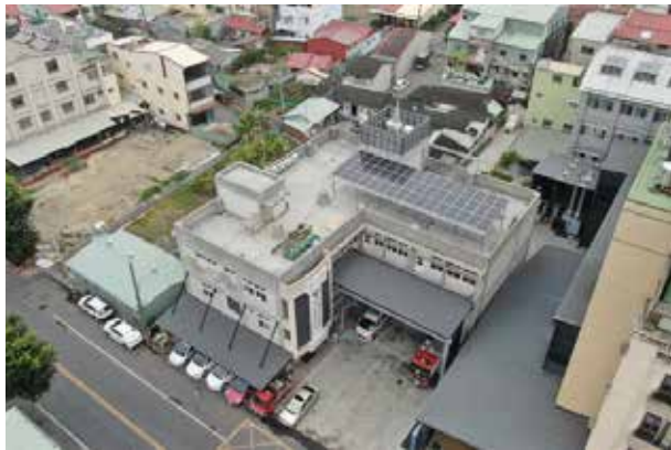
南投縣集集鎮消防分隊 裝置容量：15.36kW(瓩) 併聯日期：110.3.29
