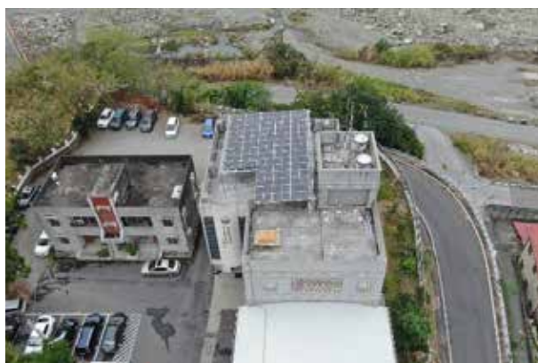
南投縣信義鄉消防分隊 裝置容量：19.2kW(瓩) 併聯日期：110.3.29
