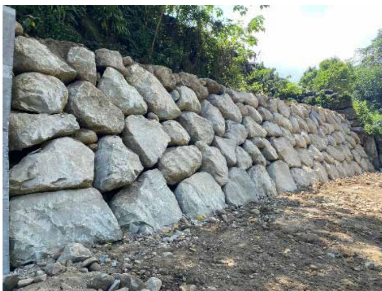
▲水里鄉玉峰村新寮坪橋下游野溪整治-砌石護岸
