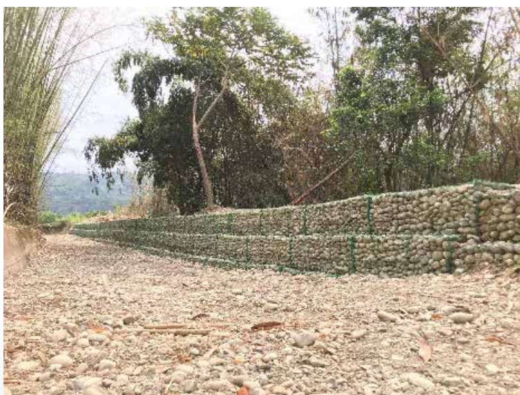
▲竹山鎮客人坑下游野溪整治-石籠護岸
