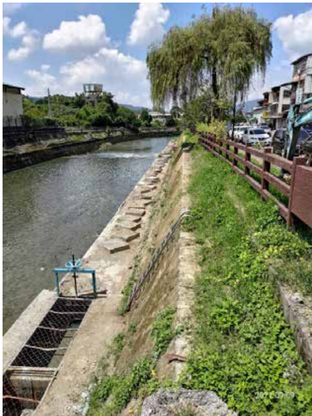
▲育英橋上下游礫間接觸設施，截留部分生活污水進行自然淨化工法改善水質
