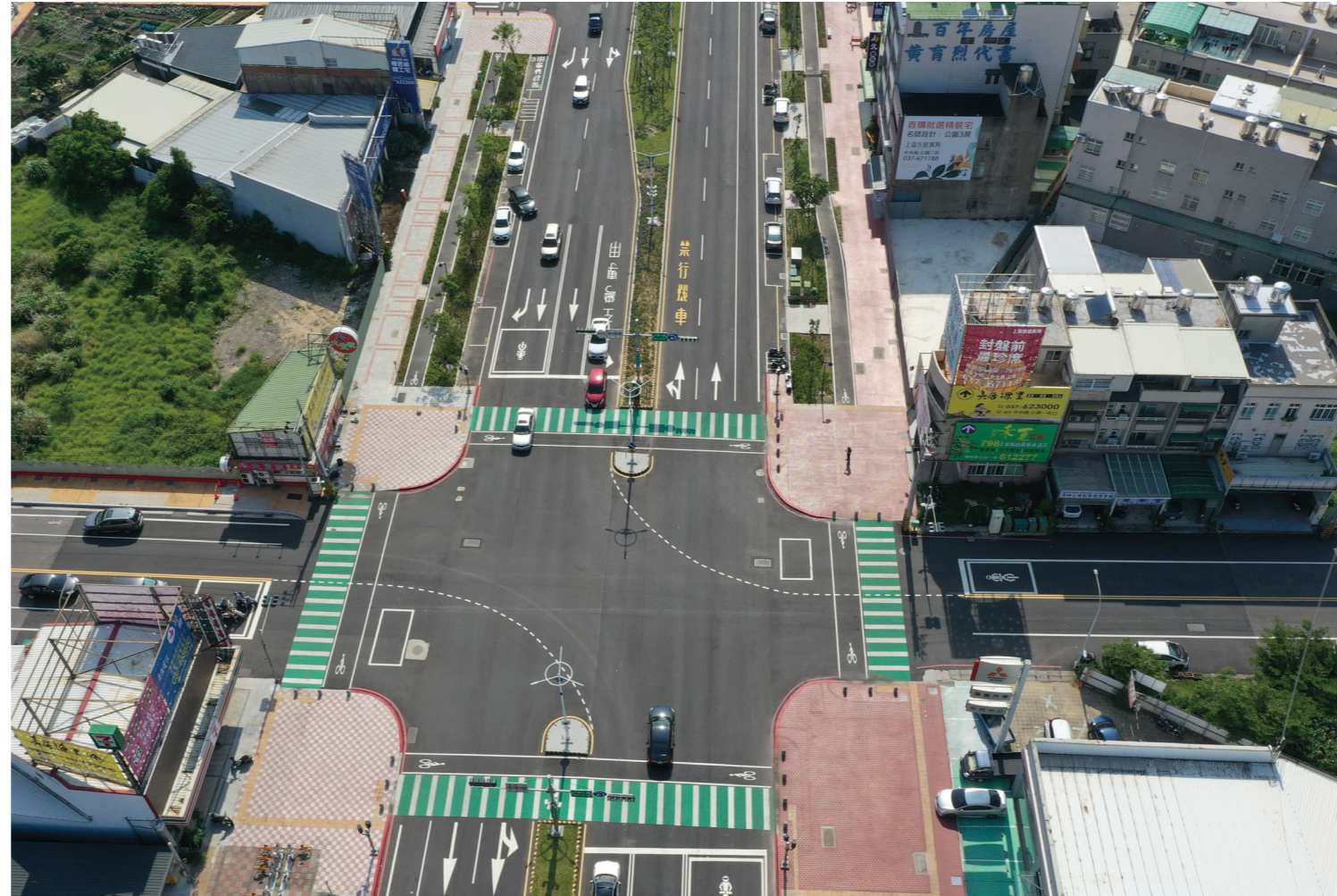
改善人行道 8,940 公尺、改善道路 2,650 公尺、改善安全島 2,100 公尺
