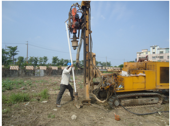
補充調查新設地下水監測井
