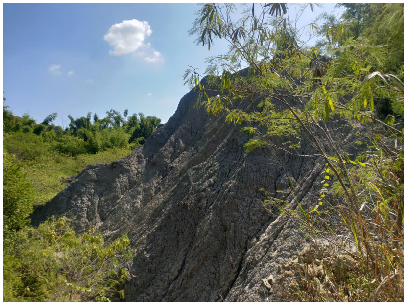
龍崎自然地景現況
