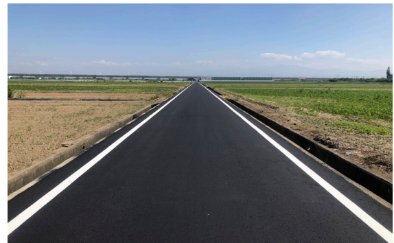
後壁農地重劃區H-8農路改善工程
