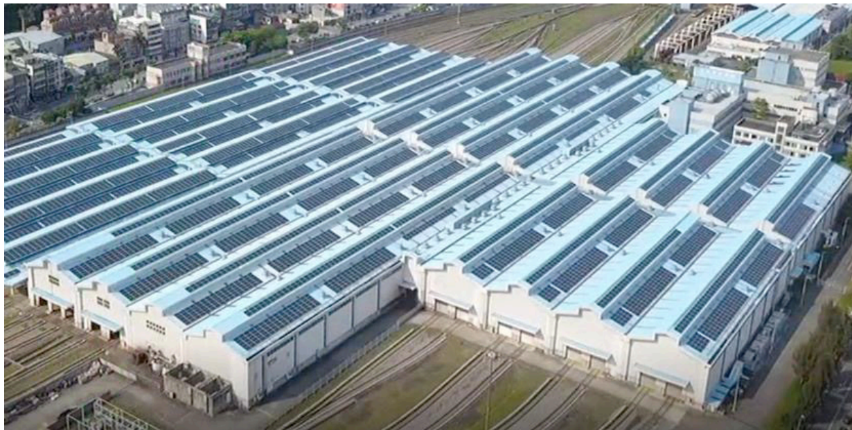
運用機廠屋頂出租設置太陽光電發電設備創造潔淨能源
