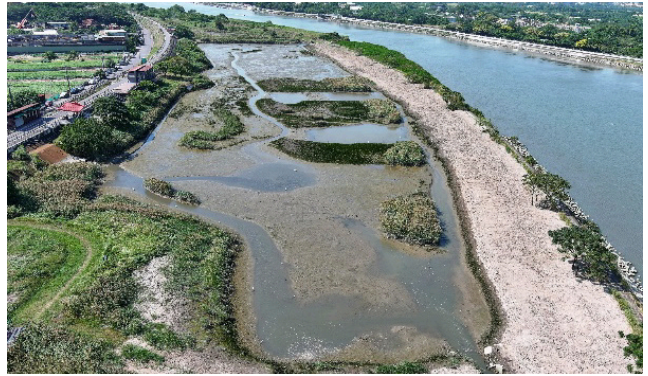
浚深後的灘地已回復感潮灘地的棲地型態
