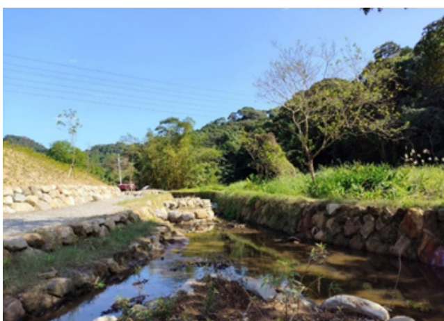
採兩階段乾砌石護岸施作，降低工程結構量體
