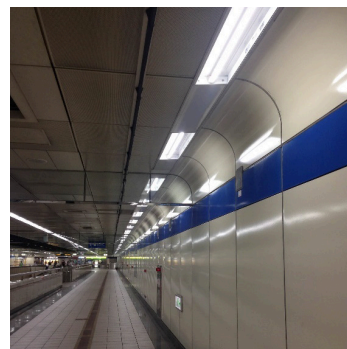
調整捷運站燈管數量，維持照度品質並達到節能成效
