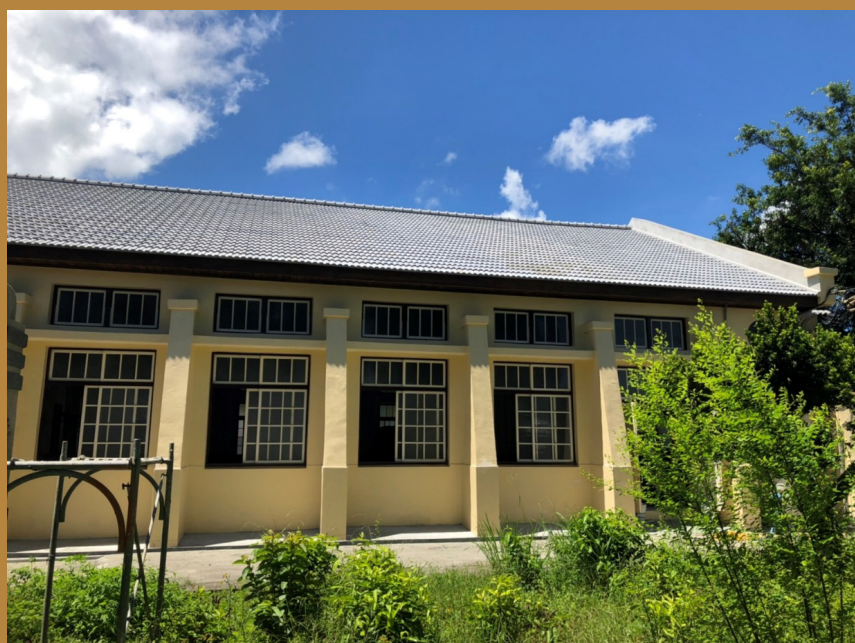
▲ 「鹽水歡雅國小原大禮堂及時鐘座修復工程」 大禮堂窗扇玻璃修復
