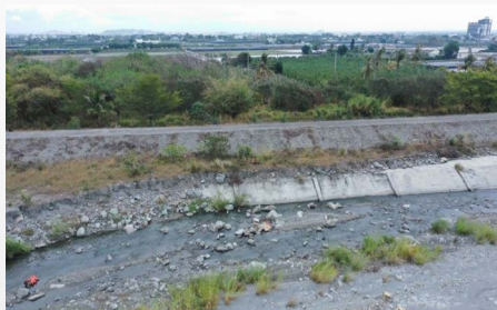
▲水利建造物（河川）定期檢查 利嘉溪
