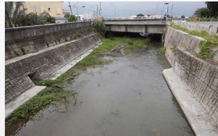
▲水利建造物（排水）定期檢查 永樂排水
