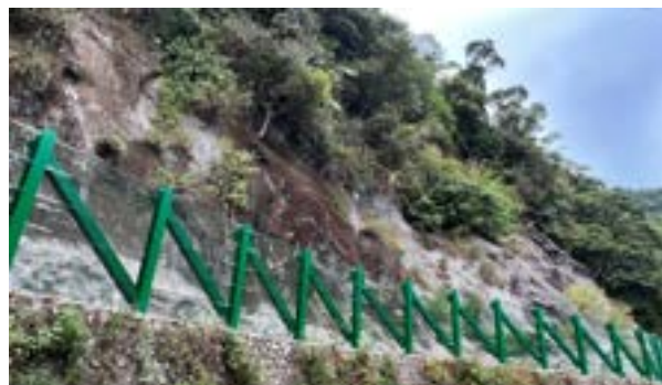
翡翠水庫邊坡新設防落石網
