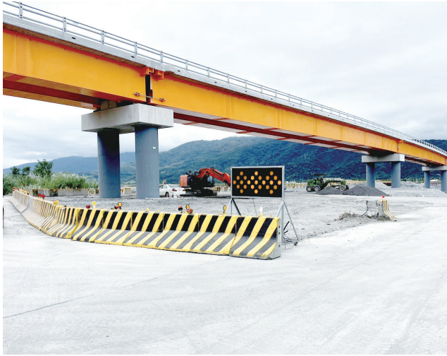
玉里高寮大橋工程 Yuli Gaoliao Bridge Construction
