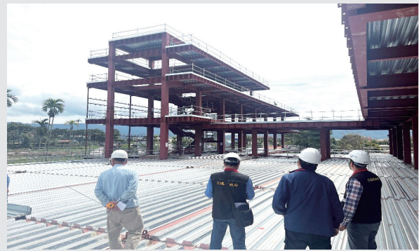
馬太鞍部落豐羽計畫工程進行中 Feng-Yu Project in Progress-Fata'an Tribe
