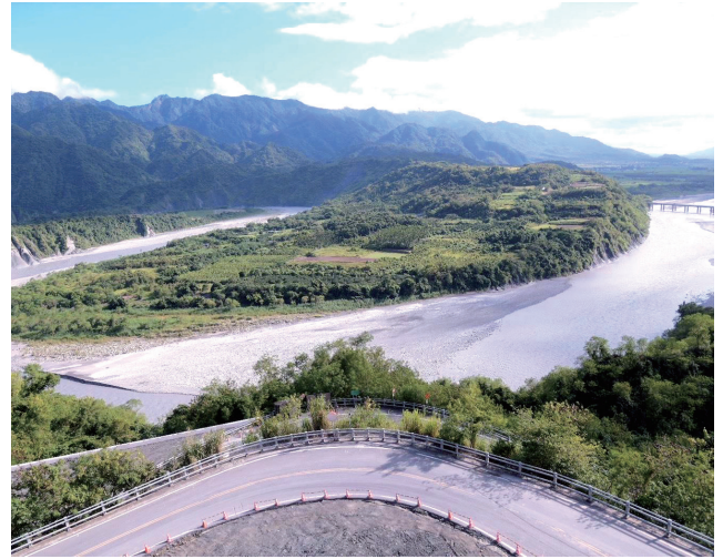
花 64 線瑞港公路改善工程 Hua 64 Line Ruigang Highway Improvement Project
