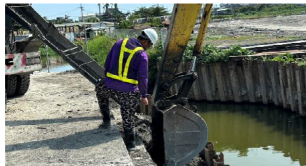
本縣焚化再生粒料使用於新闢道路工程
