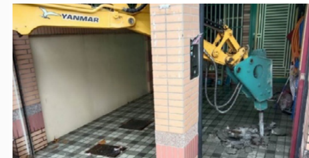
化糞池廢除施工
