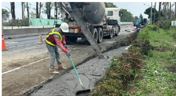
本縣焚化再生粒料使用於管溝回填
