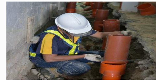
污水用戶接管施作
