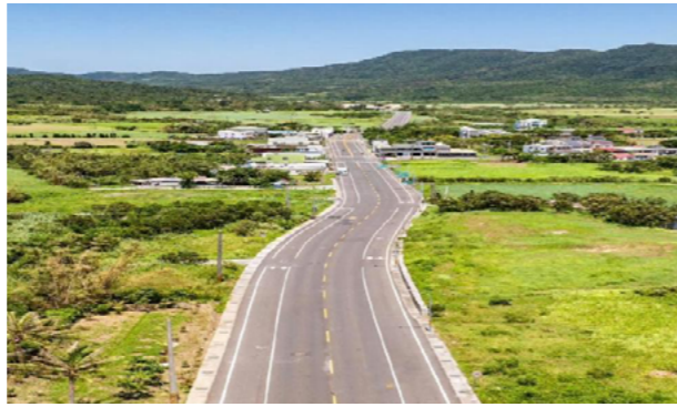
屏 200 縣道滿州鄉段桿線地下化工程完工
