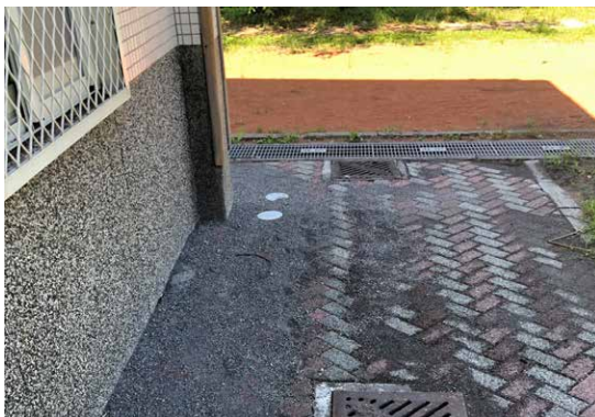
原化粪池已拆除並施設新的污水下水道管路
