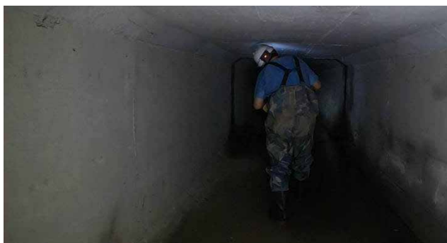
雨水下水道施工
