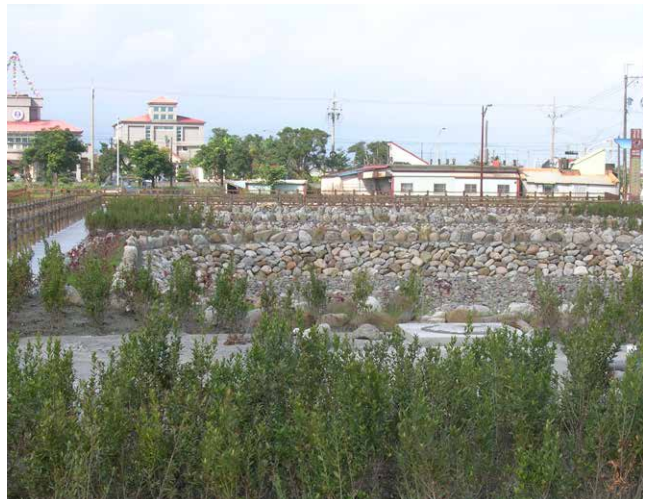
三星鄉大隱區污水自然淨化設施
