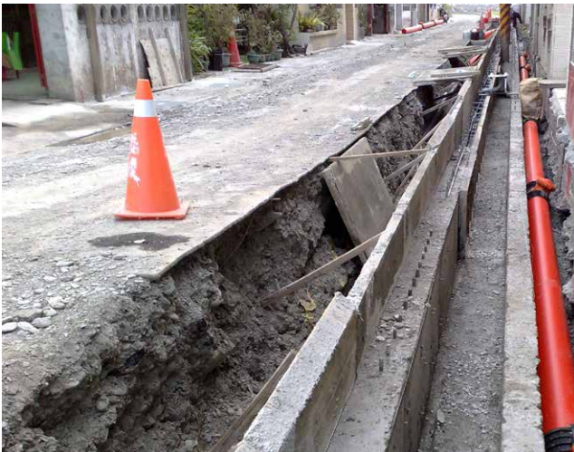
三星鄉大隱區污水管線埋設施工中
