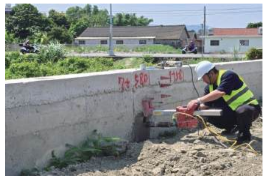
東彰道路北段新闢工程(第二標)鋼筋混凝土取樣情形 (圖/政風處)
