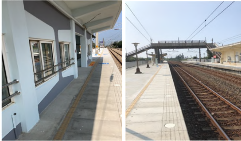
圖 14 大山站(左)及龍港站(右)完成月台提高工程
