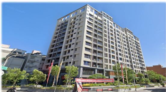
圖21 高雄全民大樂地上權住宅現況照
