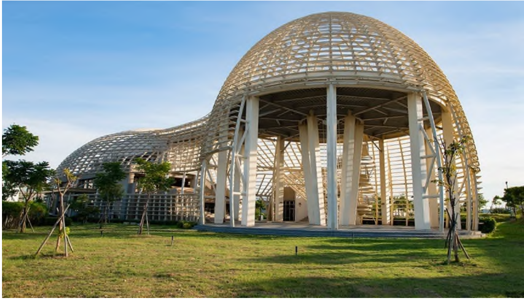
圖 3-1 桃園市促進民間參與桃園縣桃園地區污水下水道系統建設之興建、營運、移轉計畫案
