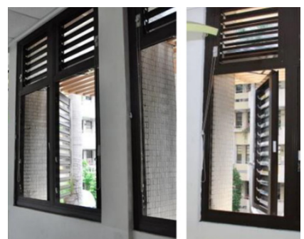
圖 3-69 改善窗戶形式，有效增加通風排熱效果，降低教室高溫不適
