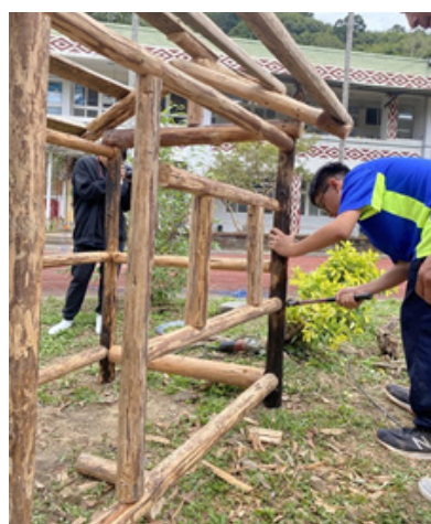
圖 3-21 透過小型竹屋的搭建了解傳統建築技藝
