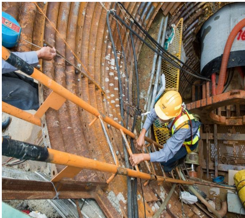
圖 11 施作污水下水道管網推進工程
