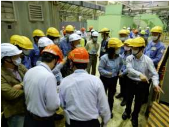
圖 5 原能會審查小組 110 年 3 月 12 日執行核一廠汽機廠房設備拆除區域現場視察(一)
