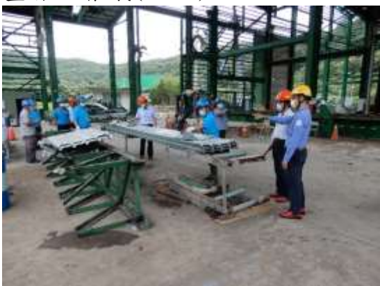
圖 9 原能會視察員 110 年 10 月 18 日查證核一廠氣渦輪機廠房拆除廢棄物輻射量測作業
