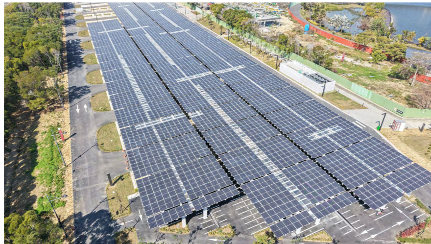
■ 南部院區南側停車場設置太陽光電發電系統
