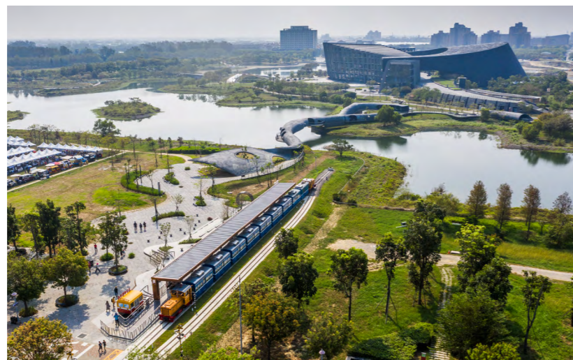
■ 南部院區五分車月台廣場及覽月橋開放使用
