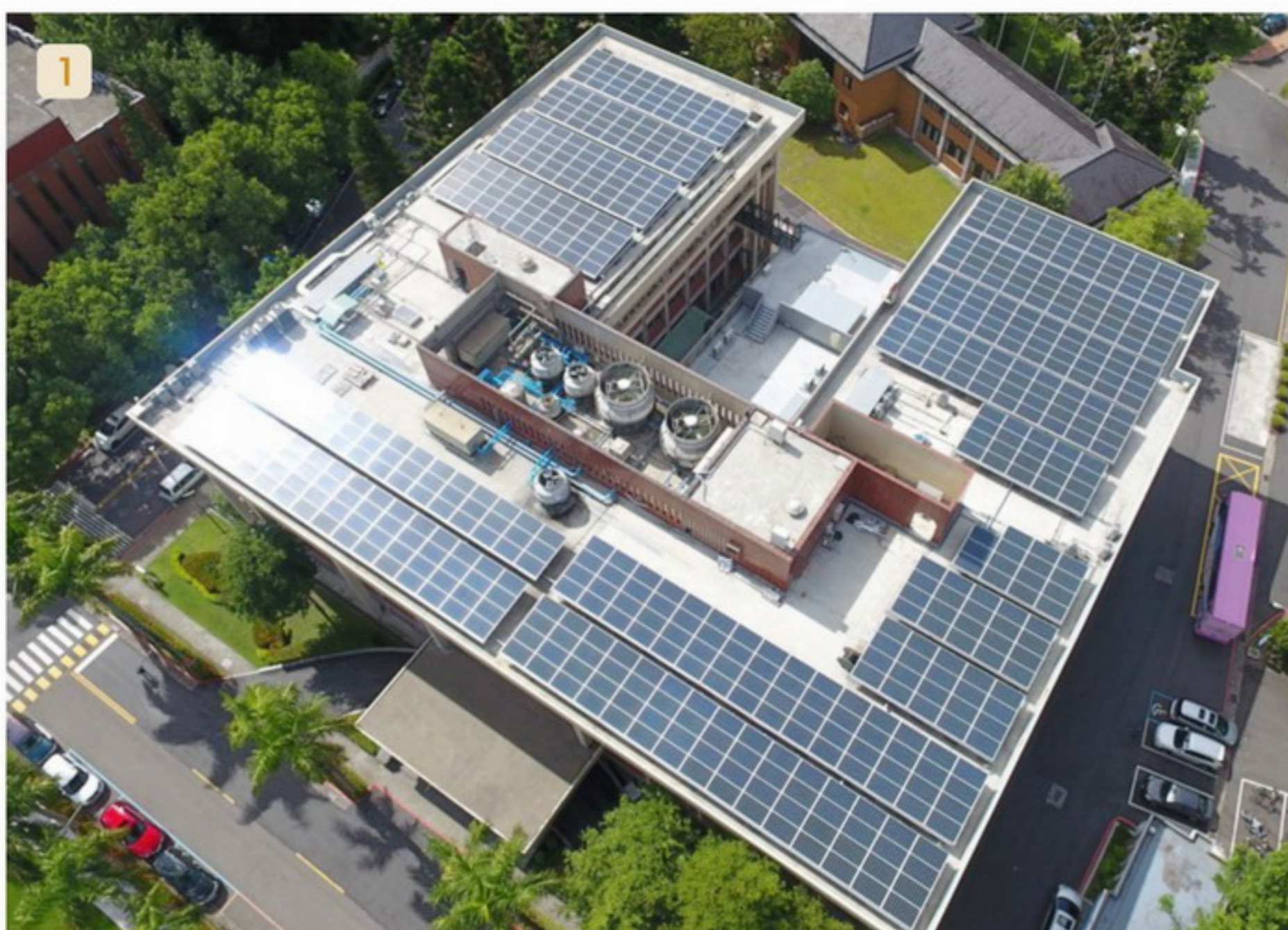
1 行政大樓屋頂建置太陽能發電設備
