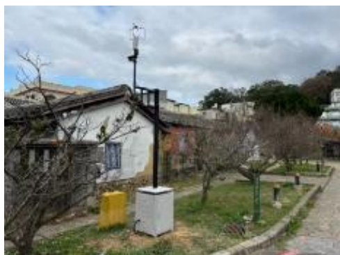
保存環境監測設備（金廣福公館— 超音波三維風向風速計）
