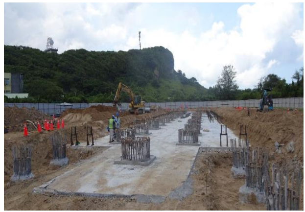
圖20、核二廠室外乾貯設施興建中
