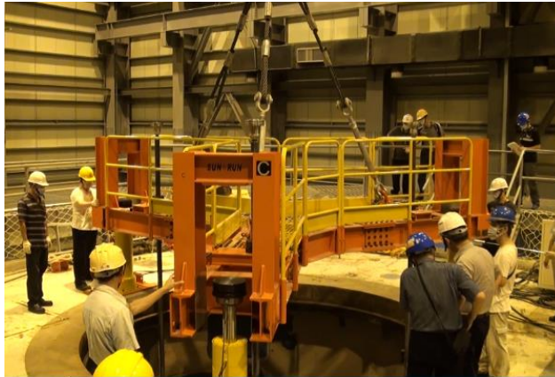
圖26、Y型鬆動機具測試作業
