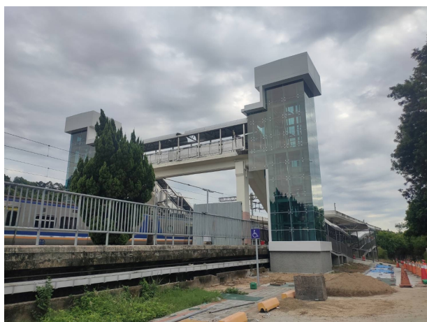
▲ 圖2-18 臺鐵造橋站無障礙電梯建置
