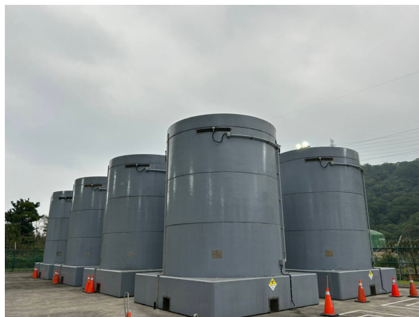
▲ 圖2-35 第一核能發電廠室外乾貯運貯執行情形
