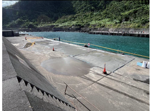
▲圖 2-39 113 年 7 月完成碼頭混凝土面版修復
