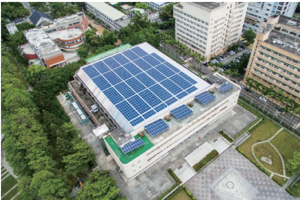
▲圖 3-3 永續獎教育類得主 - 國立中興大學：校舍屋頂設置太陽能光電的儲能系統與充電樁等設施，邁向達成能源自主、淨零碳排的目標
