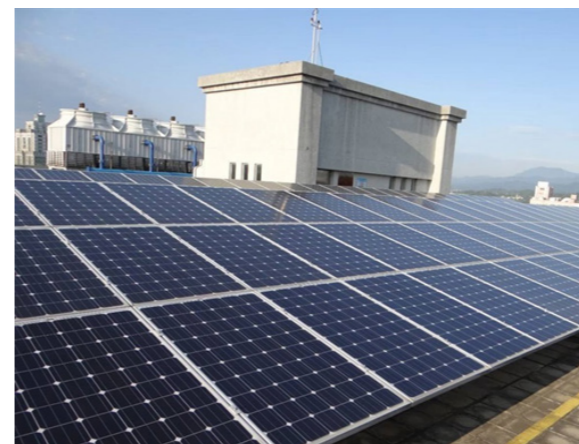
▲苗栗縣政府辦公大樓屋頂太陽光電發電系統建置 2
