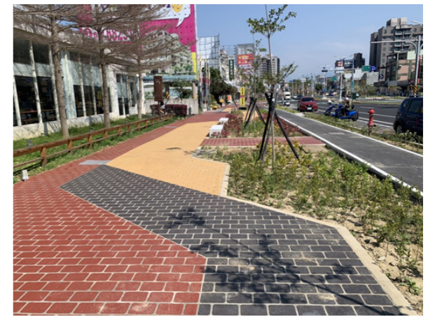
▲斜交路口鋪面改善
