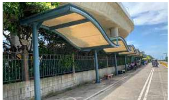
看海公園旁，木作階梯檢修上漆 / 十七公里波浪涼亭，除銹上漆
