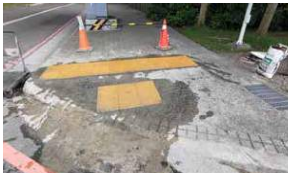
本市公道五路與建功一路 - 改善前 / 改善後
