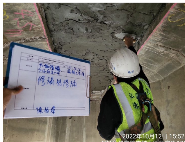
梁底混凝土修復
