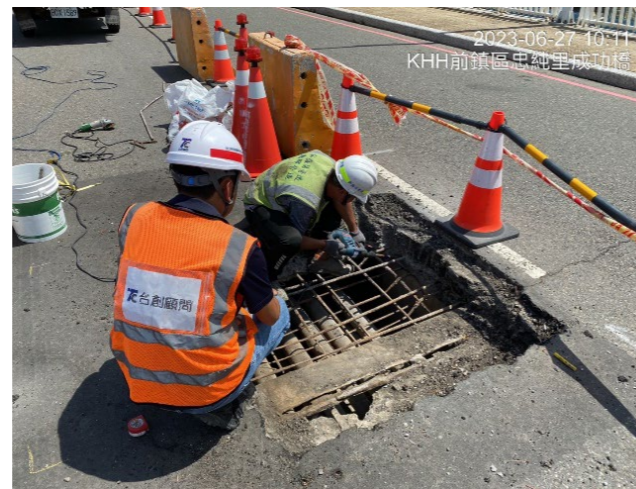
橋面面板局部修復
