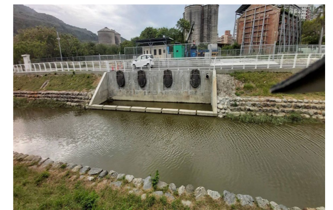
鼓山區鼓山三路抽水站工程
