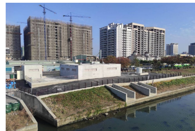
楠梓援中抽水站工程
