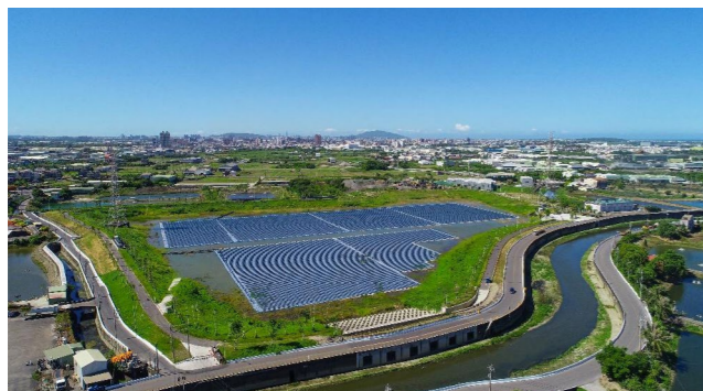
五甲尾滯洪池太陽光電設置 4,999kWp
