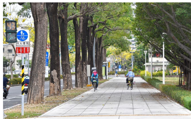
人行道改善工程
