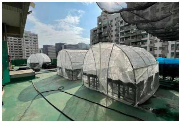
楠梓區翠屏里活動中心建置屋頂農場及隔熱網降低室內溫度
